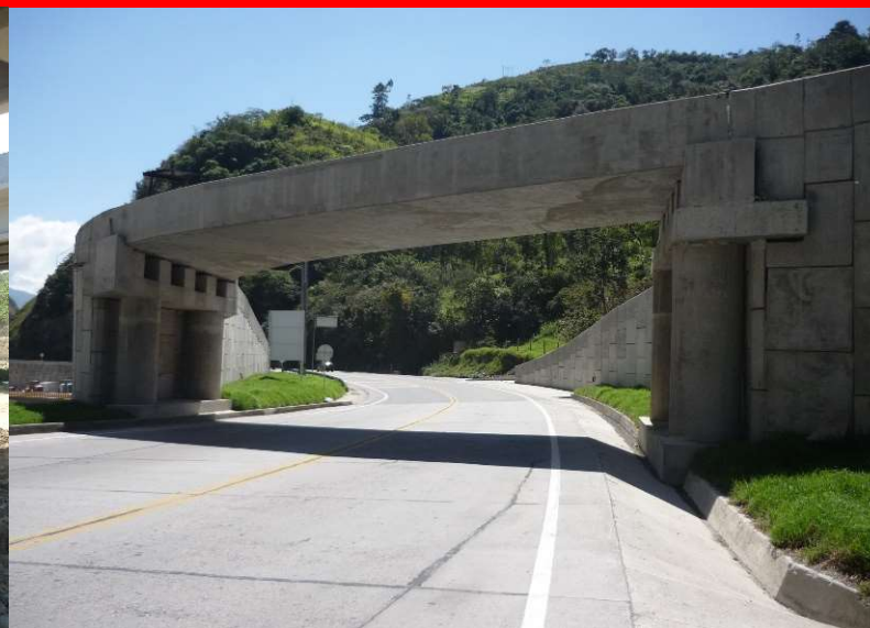
Muros Puente Quetame - Vía Bogotá Villavicencio
